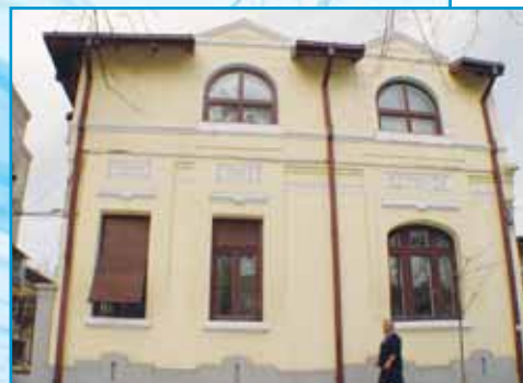
Η UNIAXIS SRL – MARAC GROUP απέκτησε νέες εγκαταστάσεις στο Βουκουρέστι Η UNIAXIS S.R.L. θυγατρική εταιρία της ΜΑΡΑΚ ΗΛΕΚΤΡΟΝΙΚΗ Α.Β.Ε.Ε. απέκτησε σε κεντρική περιοχή του Βουκουρεστίου το εικονιζόμενο νεοκλασικό κτίριο Γραφείων 600 τ.μ. για την εγκατάσταση των γραφείων της.
